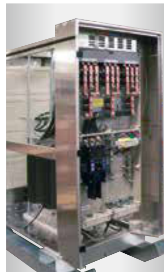
Abwärtstrafo: Vorder- und Rückseite, Eingang 1000V / Abgang 400V
